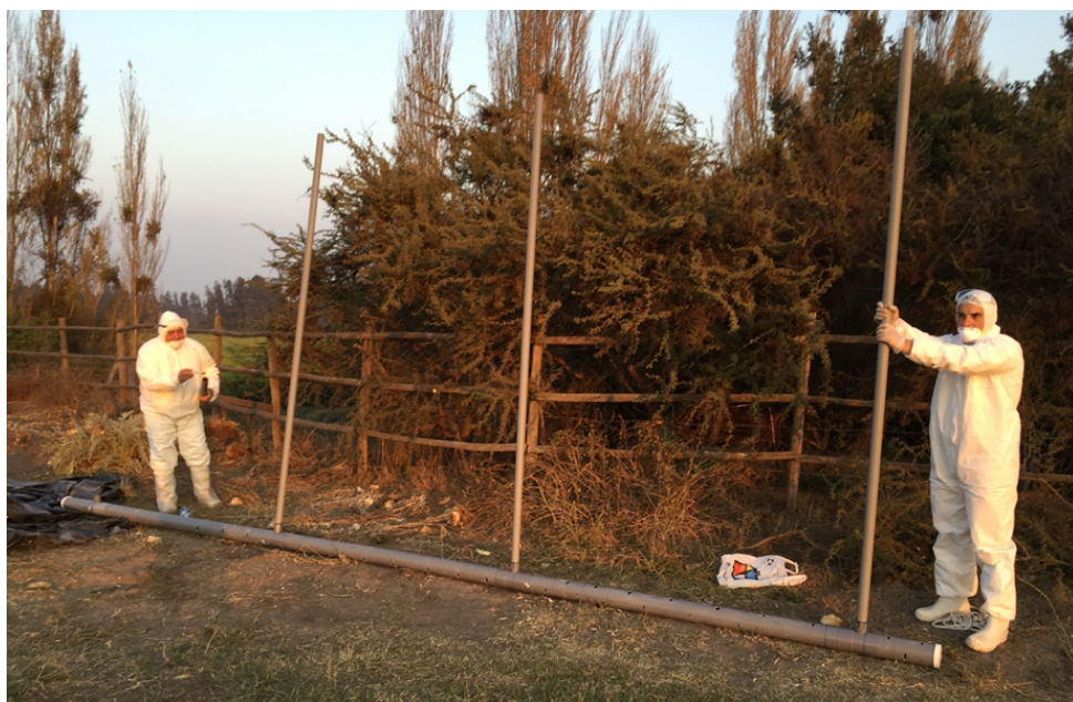
Fotografía 6. Chimeneas para evacuación de gases. Iván Ramírez
