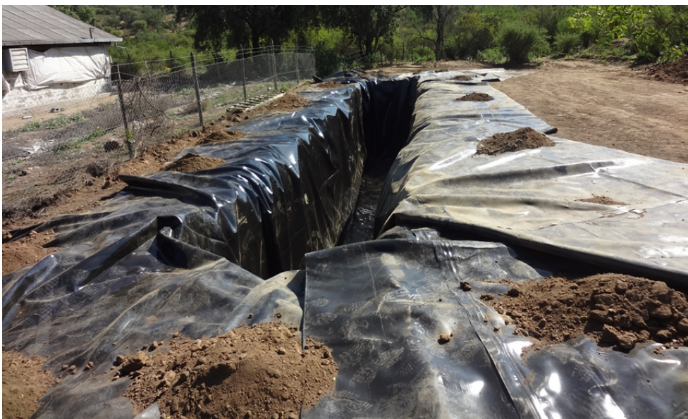
Fotografía 3. Fijación de membrana con pequeños montones de tierra. Iván Ramírez.
