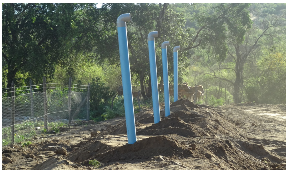
Fotografía 7. Chimeneas instaladas con codo superior. Iván Ramírez
