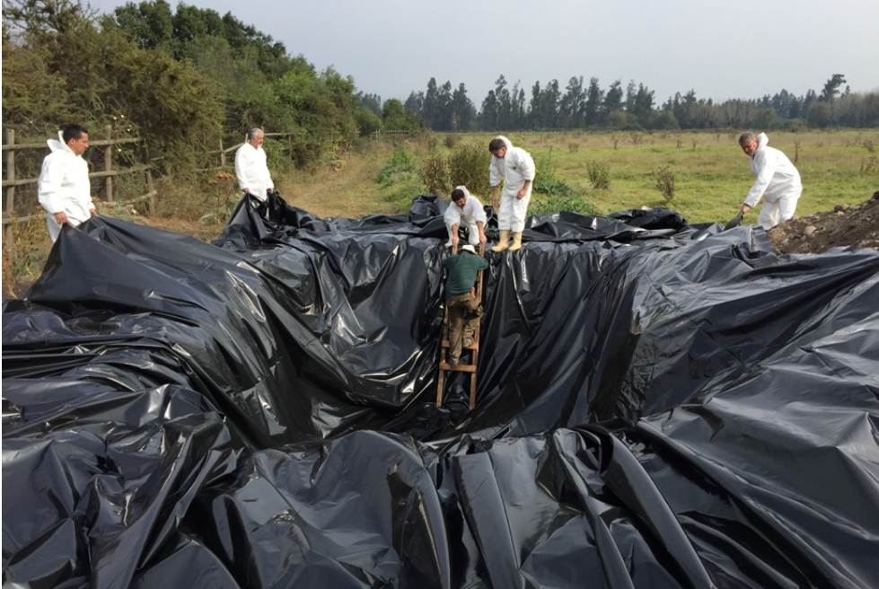
Fotografía 2. Ajuste de la membrana a la fosa excavada. Iván Ramírez.
