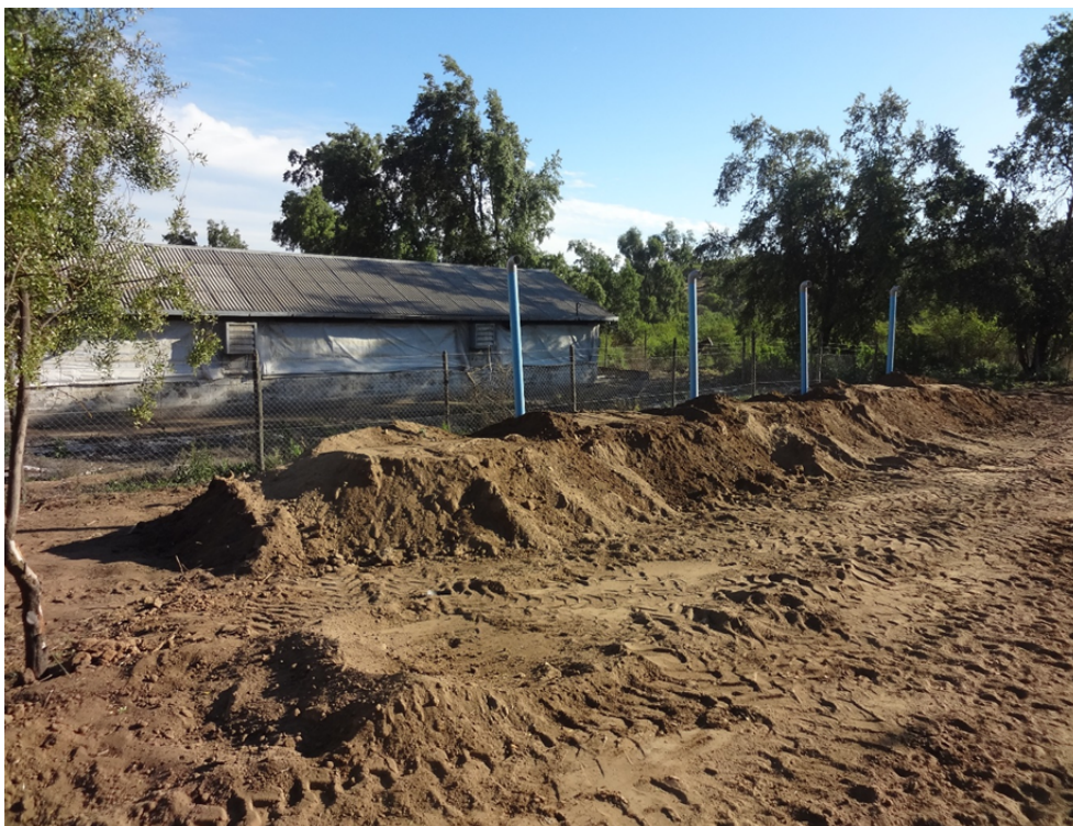
Fotografía 8. Sello de zanja por sobre el nivel del suelo. Iván Ramírez.
