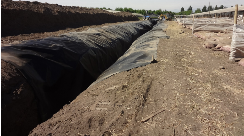
Fotografía 4. Fijación de membrana con estacas de madera. Iván Ramírez.
