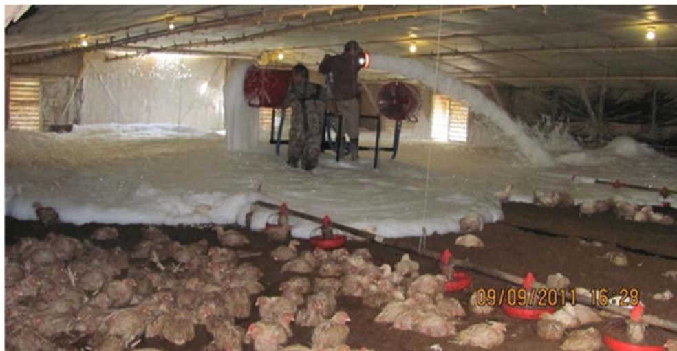
Foto 18. Inyección de espuma en gallinero de broilers.
