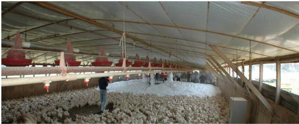
Foto 17. Inyección de espuma en gallinero de broilers.
